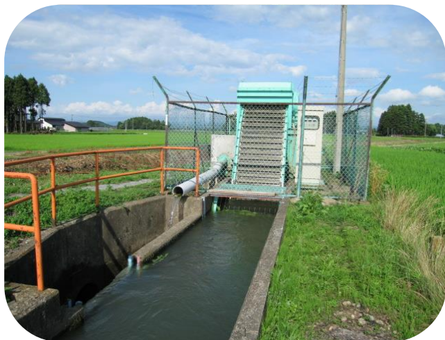
農業水路用 ロータリーネットスクレーパー式自動除塵機
