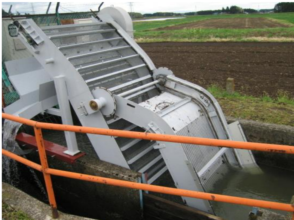
農用水路に据付
