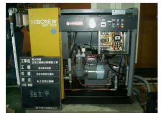
7.5kw 脱水設備プロセス圧縮機整備
