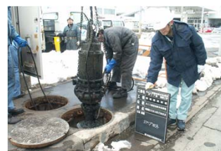
工水 調整池揚水ポンプ整備
